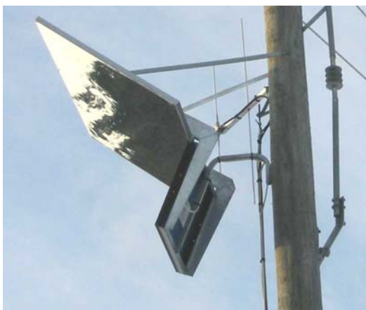
Figur 7 Reflektor med konsoler och stagning
